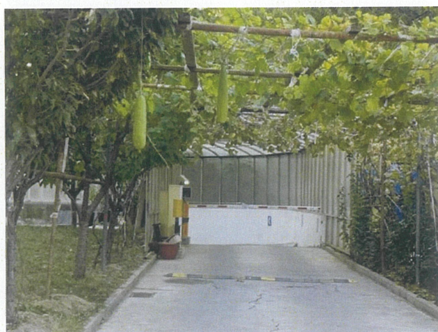
图 7.9 地下车库入口限速栏杆
