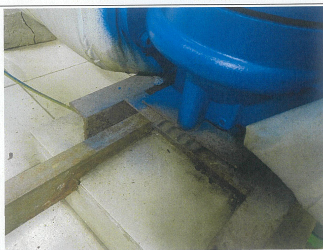
图 7.6 泵房减震基础和软连接
