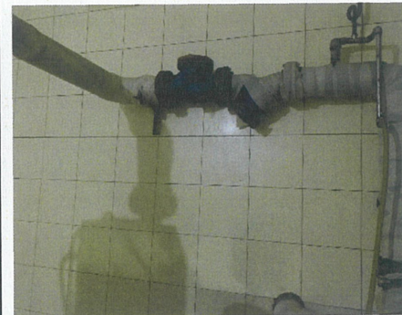
图 7.6 泵房减震基础和软连接
